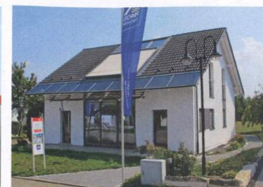
Lechner Massivhaus, Platz 42
